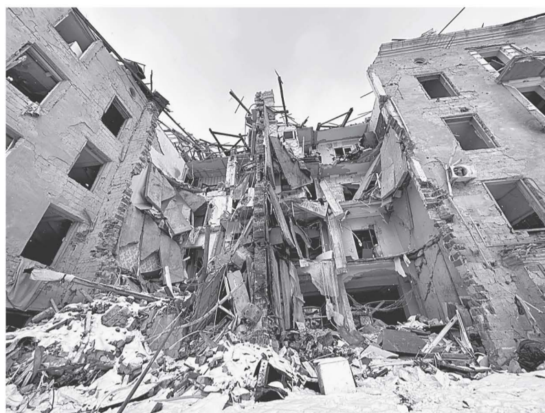
2月1日夜にあったロシア軍のミサイル攻撃で破壊されたウクライナのアパート。世界各地で紛争が絶えないウクライナ東部ドネツク州クラマトルスクで2月16日、鈴木一雄撮影
